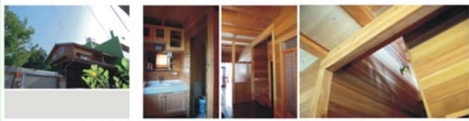
小木屋案例-全戶使用水性塗料：戶外木器專用漆、室內透氣漆
